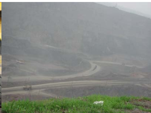
圖二、礦坑挖掘現場
